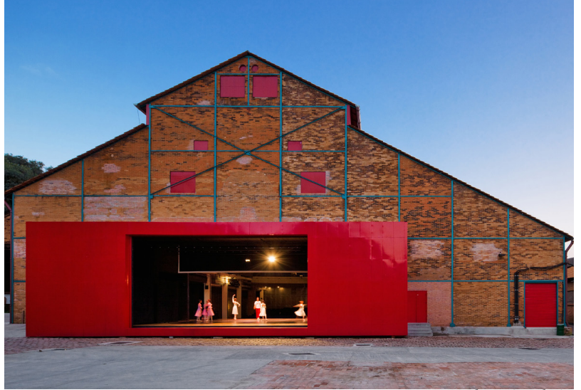
Vista exterior parte de atrás galpón
