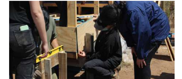
Fig.260 Sellado de panel. Elaboración propia
