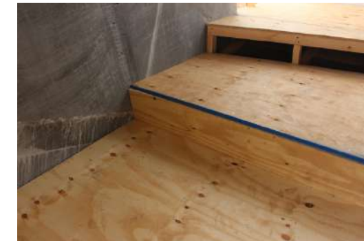
Fig.294 Colocación Contrahuellas. Elaboración propia
