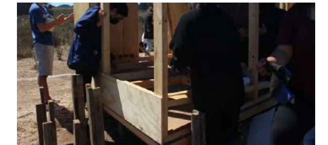
Fig.286 Sellado de panel. Elaboración propia
