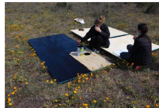
Fig.237 Pintado de placas con Carboliteo. Elaboración propia
