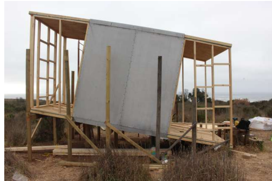
Fig.245 Marcos montados en el espacio. Elaboración propia
