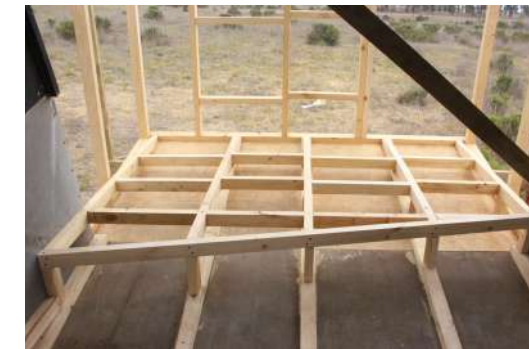
Fig.291 Colocación cadenetas. Elaboración propia
