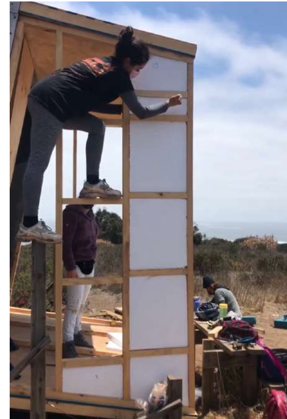
Fig.256 Colocación aislante. Elaboración propia
