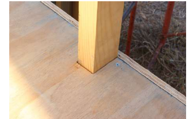
Fig.303 Encaje huella y pilar. Elaboración propia
