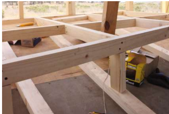
Fig.299 Estructura montada. Elaboración propia
