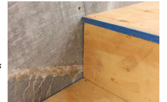
Fig.305 Ras Huella y contrahuella. Elaboración propia
