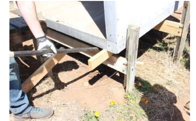
Fig.231 Uso chuzo como palanca. Elaboración propia
