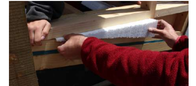
Fig.249 Colocación de Plumavit. Elaboración propia
