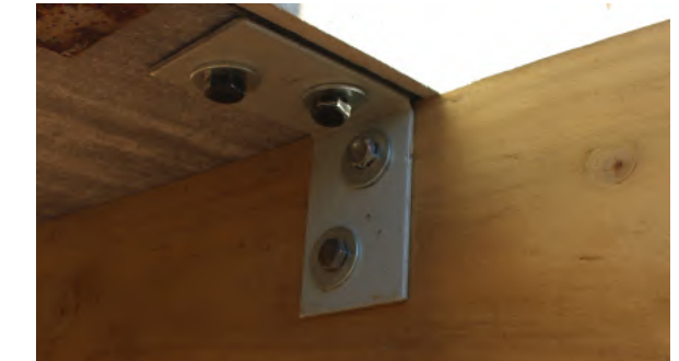
Fig.219 Pletinas montadas. Elaboración propia
