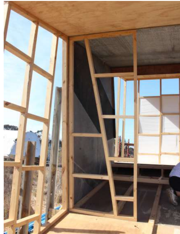
Fig. 279 Marco del panel montado en el espacio. Elaboración propia
