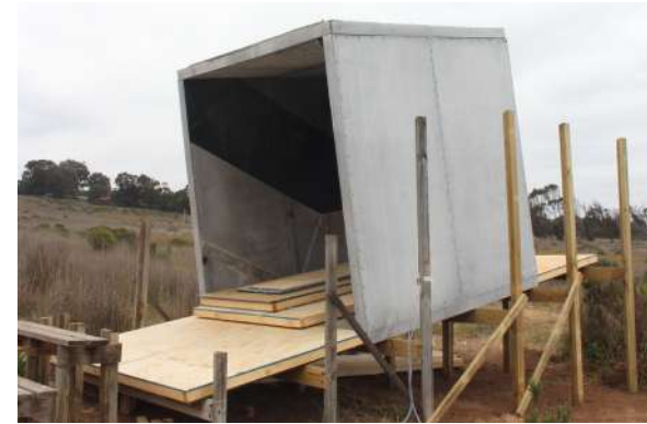
Fig.270 Montaje suelos. Elaboración propia
