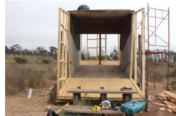
Fig.271 Montaje suelo y marcos frontal. Elaboración propia
