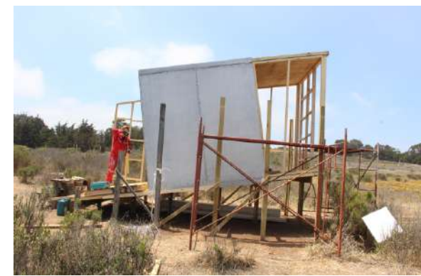
Fig.272 Montaje Marcos traseros. Elaboración propia
