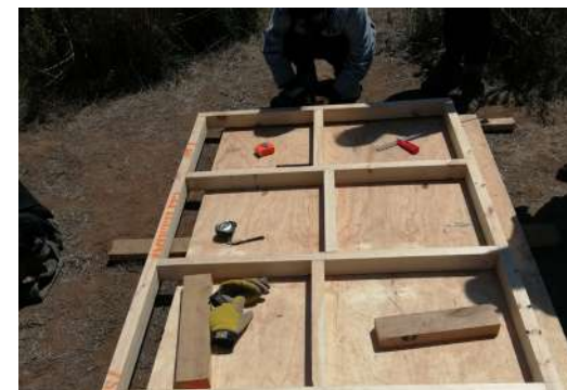
Fig.238 Armado marcos. Elaboración propia
