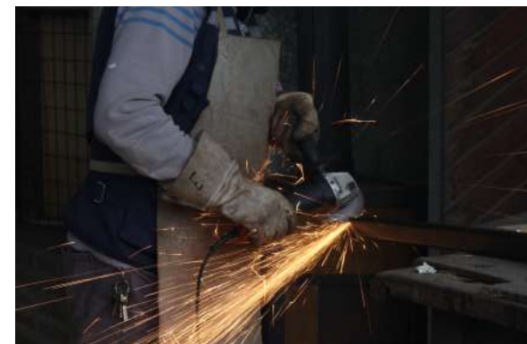
Fig.320 Cortado de fierros para estructura. Elaboración propia
