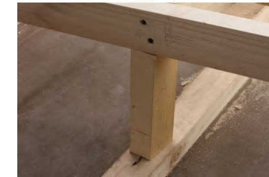
Fig.292 Colocación pies derechos. Elaboración propia
