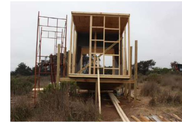
Fig.269 Marco montado. Elaboración propia
