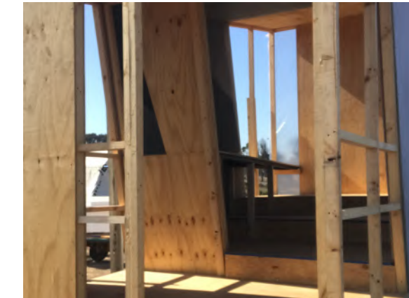
Fig.258 Marco montado. Elaboración propia
