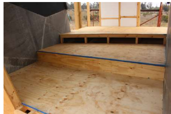
Fig.288 Construcción pisos. Elaboración propia
