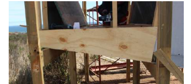
Fig.251 Sellado de panel. Elaboración propia
