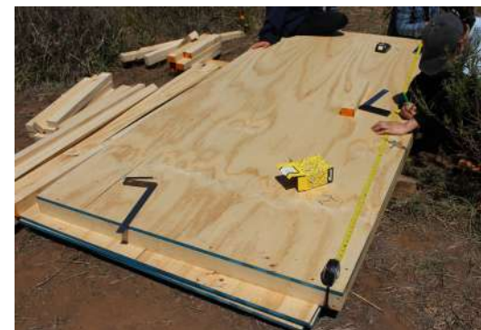
Fig.234 Construcción paneles. Elaboración propia
