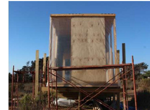
Fig.267 Marco montado. Elaboración propia
