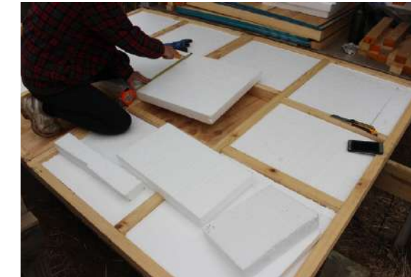
Fig.277 Colocación Plumavit. Elaboración propia
