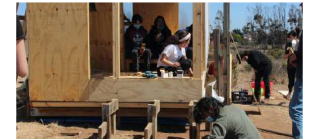
Fig.287 Sellado de panel. Elaboración propia
