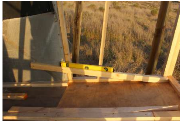
Fig.297 Nivelación Vigas. Elaboración propia
