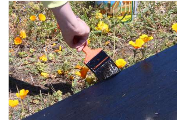
Fig.243 Aplicado Carbolineo. Elaboración propia
