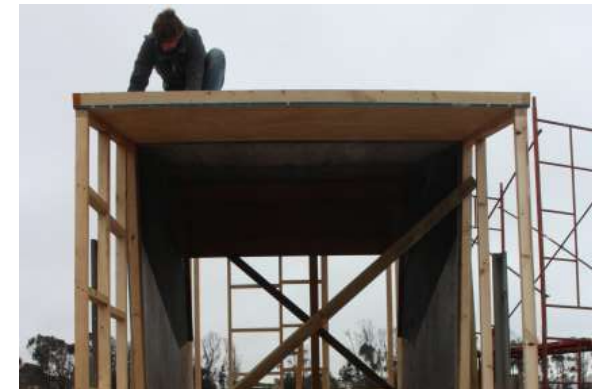
Fig.274 Montaje cielos. Elaboración propia
