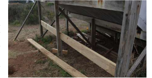
Fig.227 Vigas nuevas. Elaboración propia
