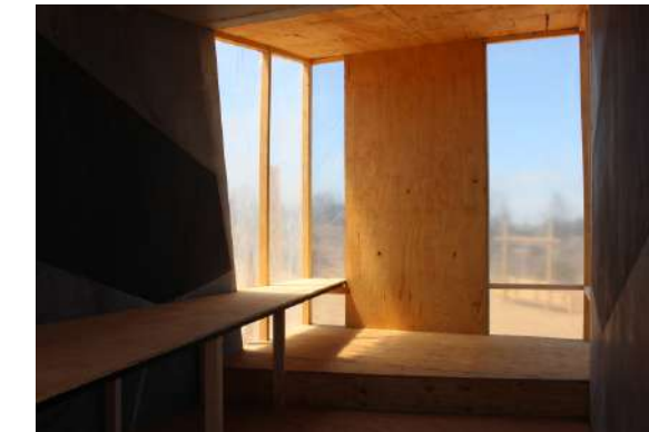
Fig.250 Marco montado desde el interior. Elaboración propia
