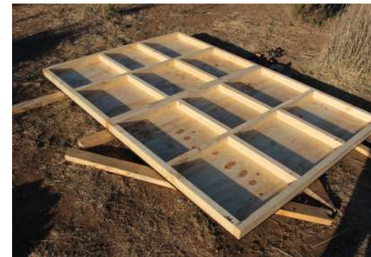
Fig.235 Construcción marcos paneles. Elaboración propia
