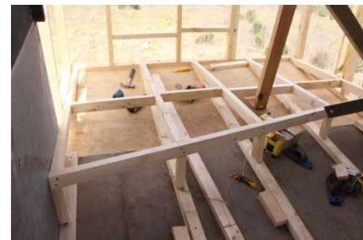
Fig.290 Construcción entrepisos. Elaboración propia
