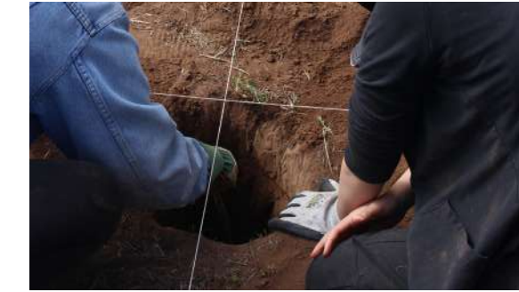
Fig.224 Escavado de hoyos para el montaje de la estructura. Elaboración propia
