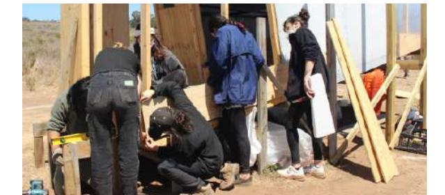
Fig.261 Sellado de panel. Elaboración propia
