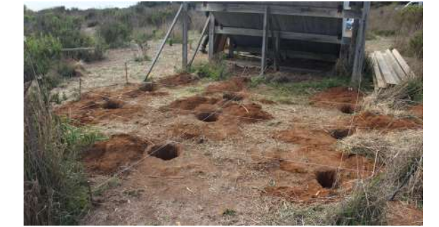
Fig.225 Terreno perforado para el montaje de la estructura. Elaboración propia
