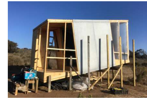
Fig.259 Marco montado. Elaboración propia
