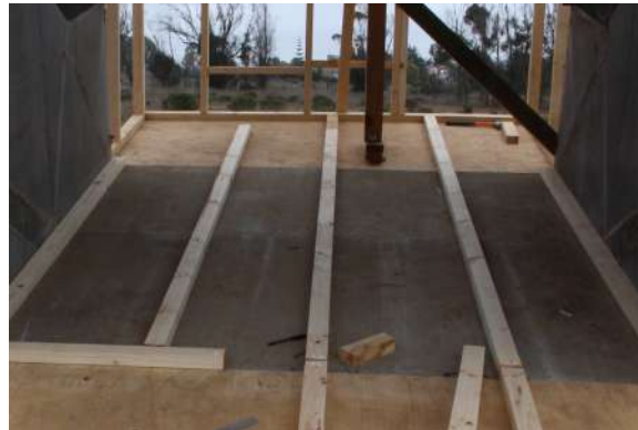
Fig.295 Colocación listones. Elaboració propia
