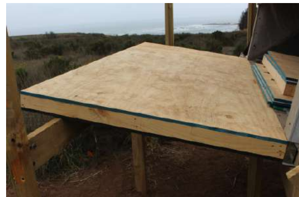
Fig.232 Panel piso trasero, montado. Elaboración propia
