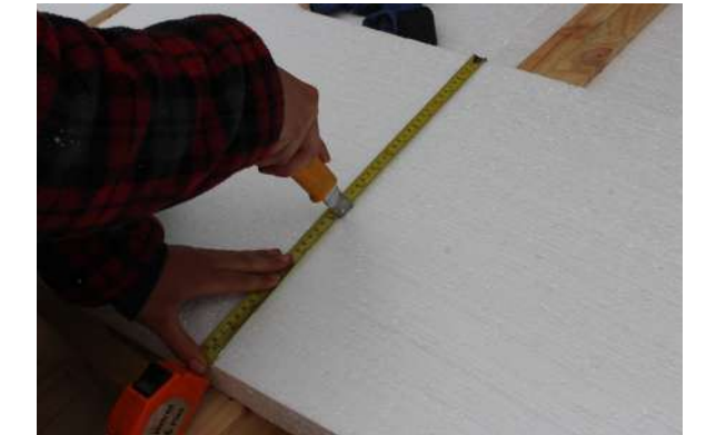
Fig.278 Corte plumavit. Elaboración propia
