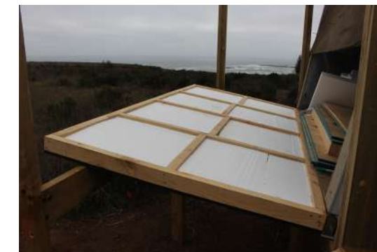
Fig.239 Plumavit montada. Elaboración propia
