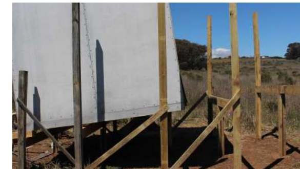
Fig.220 PPilotes y vigas montadas. Elaboración propia
