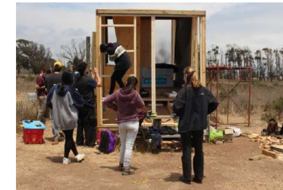
Fig.284 Marco montado. Elaboración propia
