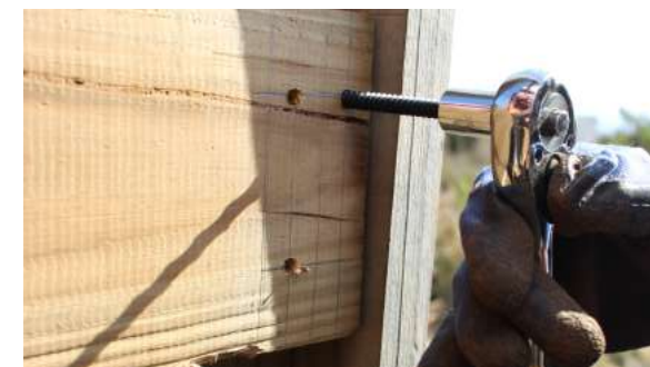
Fig.218 Anclaje vigas, uso de chicharra. Elaboración propia
