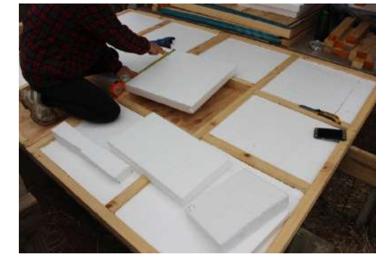
Fig.236 Colocación de plumavit. Elaboración propia
