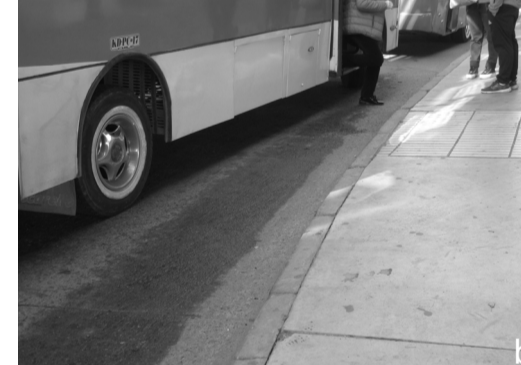
Paradero irregular, no hay señalización ni alerta táctil y se presenta un desnivel no "reparado" entre la calzada y la vereda.
