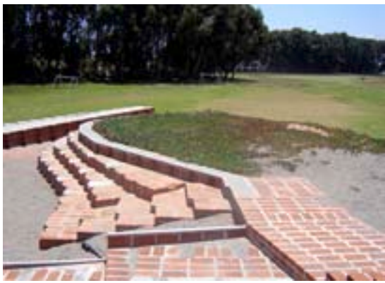
Calzadas de las Aguas: piletas, siales y pavimentos en relación al entorno.
