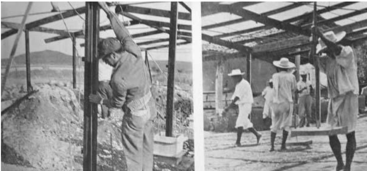
Figura 1. Faenas de construcción de un Aula-Casa Rural en México (Ramírez Vázquez, 1963, 420).
