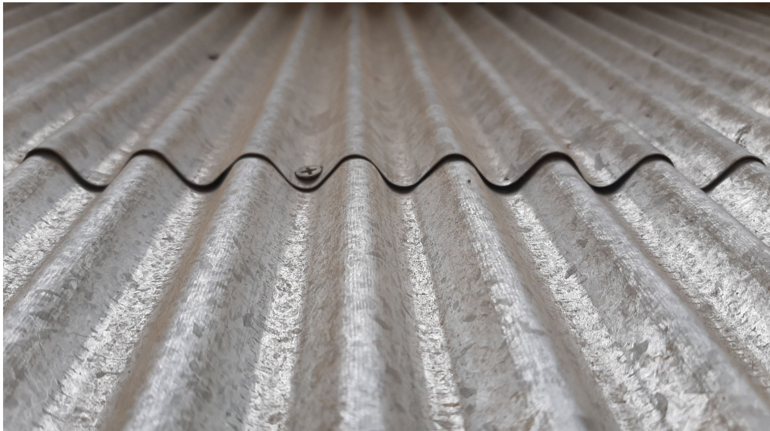
Hay un cuidado en el calce de las planchas para lograr una perfecta continuidad.
