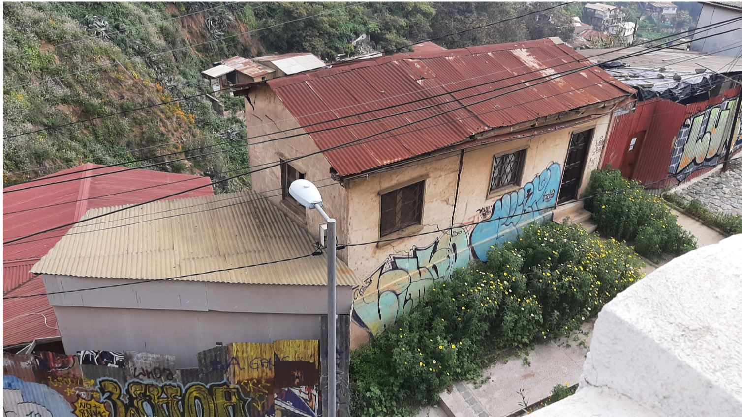
Se pueden encontrar distintas combinaciones de usos, colocación y tamaños de ondas de la plancha de calamina.
