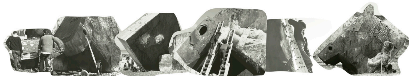
Planificado por JR - Montaje realizado entre el equipo de trabajo
