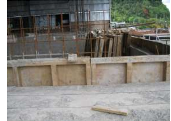
Faneas de Encofrado para las plataformas, realizadas en galpones en tierra firme. Luego las plataformas son arrastradas hacia el agua cuando sube la marea.
