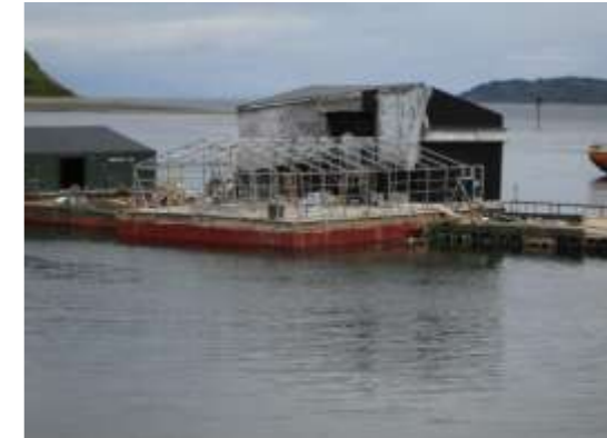
Faneas de Estructuración metálica del edificio. Una vez que la plataforma de hormigón está terminada y en el agua, se levanta el edificio con los métodos tradicionales. En la primera foto y atrás, se ven los galpones del hormigoneado.
