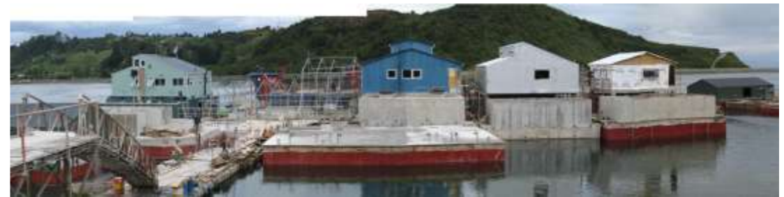
Panorámica de las casas flotantes de FERROSUR
