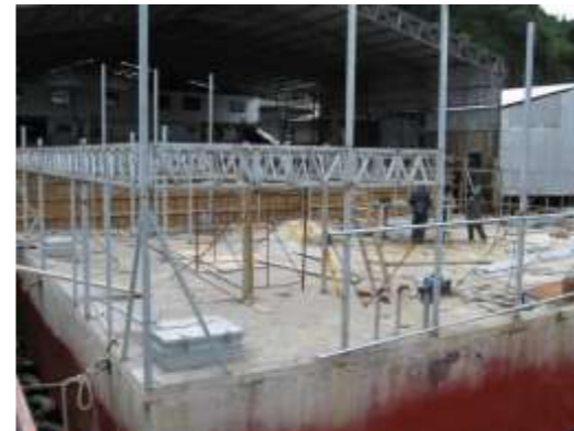
Faneas de Estructuración metálica del edificio. Una vez que la plataforma de hormigón está terminada y en el agua, se levanta el edificio con los métodos tradicionales. En la primera foto y atrás, se ven los galpones del hormigoneado.
