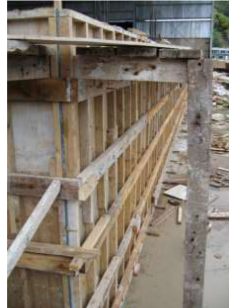
Faneas de Encofrado para las plataformas, realizadas en galpones en tierra firme. Luego las plataformas son arrastradas hacia el agua cuando sube la marea.
