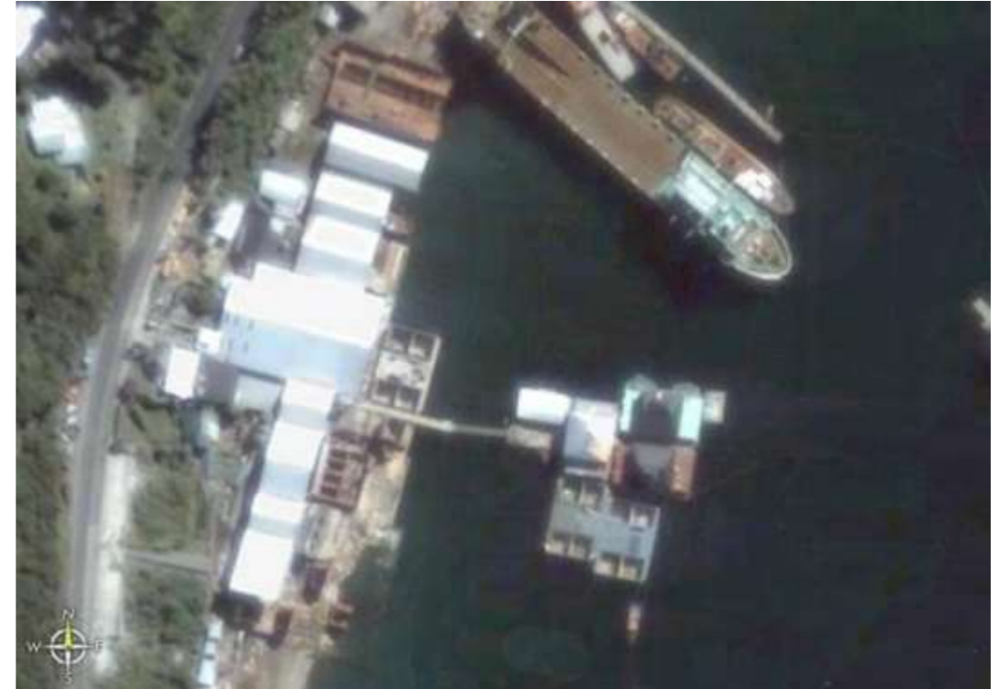
Vista de las instalaciones de FERROSUR
