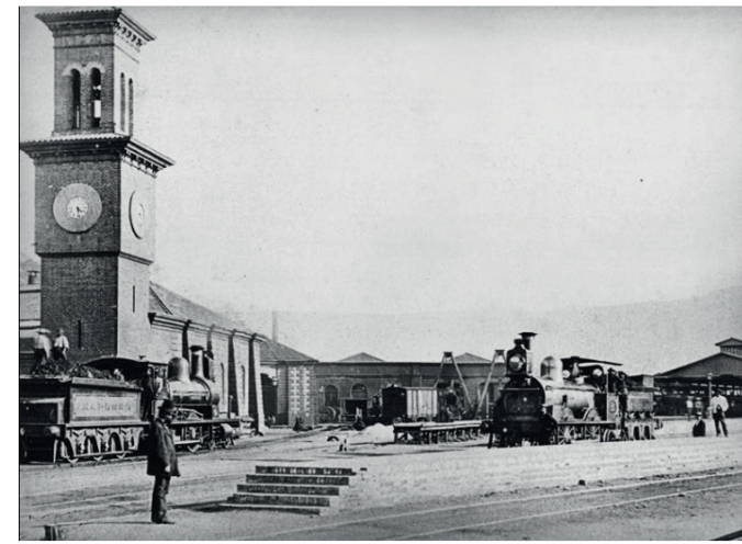
Antigua estación Barón (Torre declarada monumento nacional 1972) / (Edificio suspendido sobre un puente que se apoyaba en los muros de canalización del estero Las delicias, es decir, transversal al actual eje de Av. Argentina).
