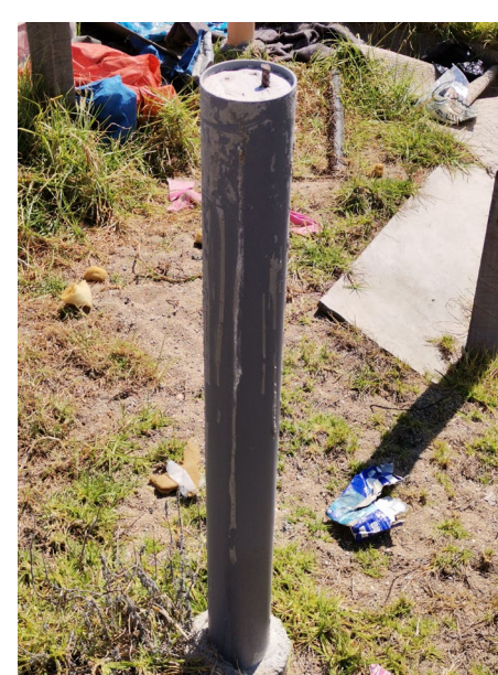
Fundación construida en Laguna Verde, se observa una pieza de hierro de armadura en el medio, probablemente para generar la unión con madera
