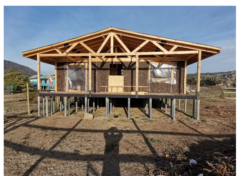
Vivienda en Laguna Verde, elevada, con las fundaciones realizadas en PVC relleno de hormigón. Este sistema se comienza a replicar en el sector, y genera interés debido a su economía y facilidad en el moldeaje.
