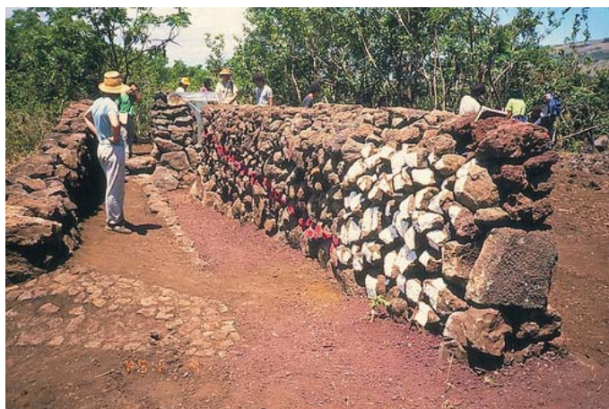
Imagen 22 y 23. Fotografía de la obra en Isla de Pascua.
