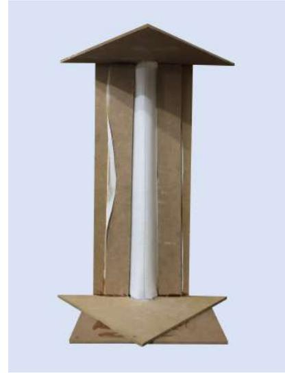
En la imagen a la derecha se ve el moldaje ya relleno de mezcla, recordar introducir el alambre en el centro, ya que este servirá para darle firmeza.
