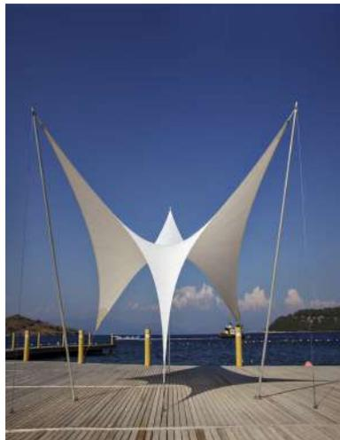
El término tensoestructura se ocupa principalmente para estructuras que mezclan membranas y cables de acero para construir grandes cubiertas, que principalmente son resistentes a la tracción, la prefabricación y la maleabilidad formal. Es de poco requerimiento material, debido a que sus lonas son delgadas y estirables, lo cual logra abarcar superficies que están más allá de su límite predeterminado.
