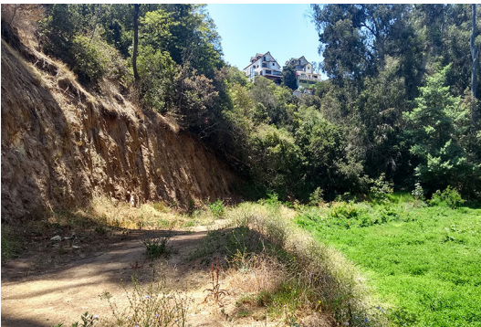
Sector 2do desarenador. Talud en el cerro.
