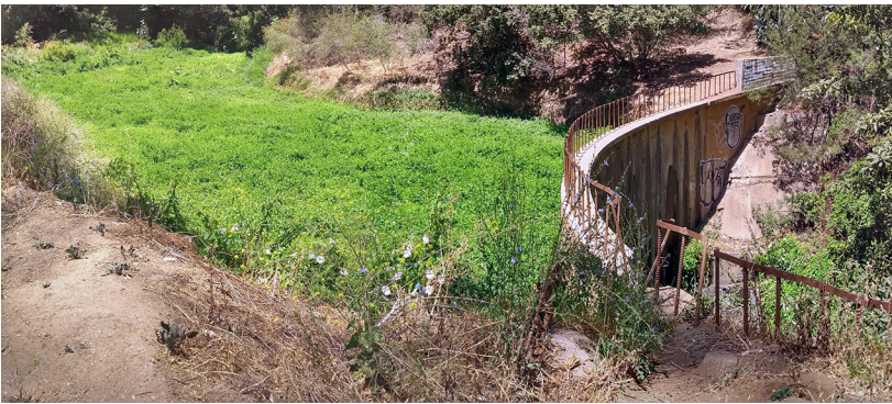
2do desarenador. Se encuentra al final de un sendero inhabilitado, por lo que se presta prácticas inseguras.
