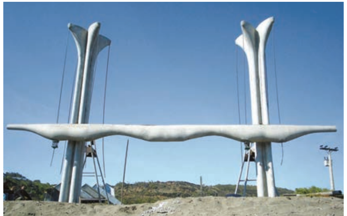
Montaje de pórtico en Ciudad Abierta, Ritoque, 2005 Portico mounting in Ciudad Abierta, Ritoque, 2005
