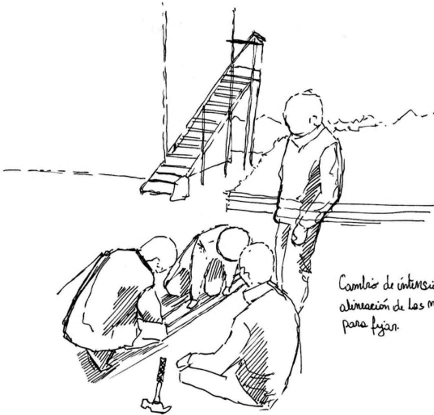
Cambio de intensidades, determinación de la alineación de las maderas antes de martillarlas para fijar.
