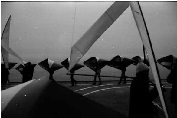
AC rec 82 - recepción 1º año (av. España, vía elevada trunca) - 023
