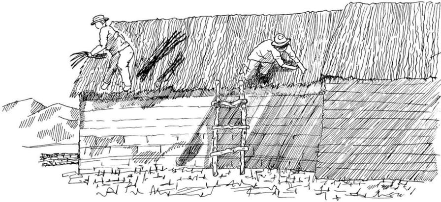
101.- hombres techando una casa aymara en quelga. Forman un manto de capas de paja grueso con barro para la protección de los vientos. La resistencia de la estructura ante el peso del hombre nos muestra la capacidad que tiene de protección e intimidad del interior al no haber filtraciones.
