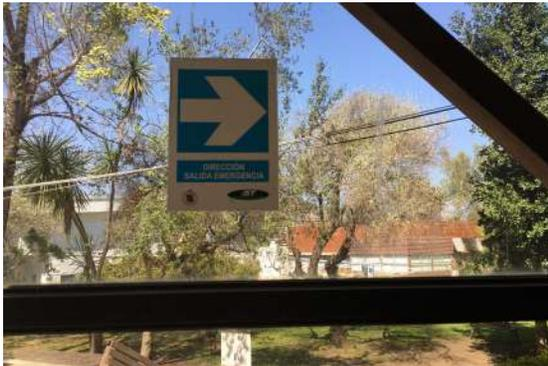
Figura 174. Señalización indicativa de Salida de Emergencia notoriamente desgastada por luz solar. Elaboración propia.
