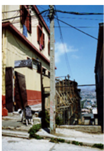
Entrada Al Ascensor Por Calle Eusebio Lillo.
