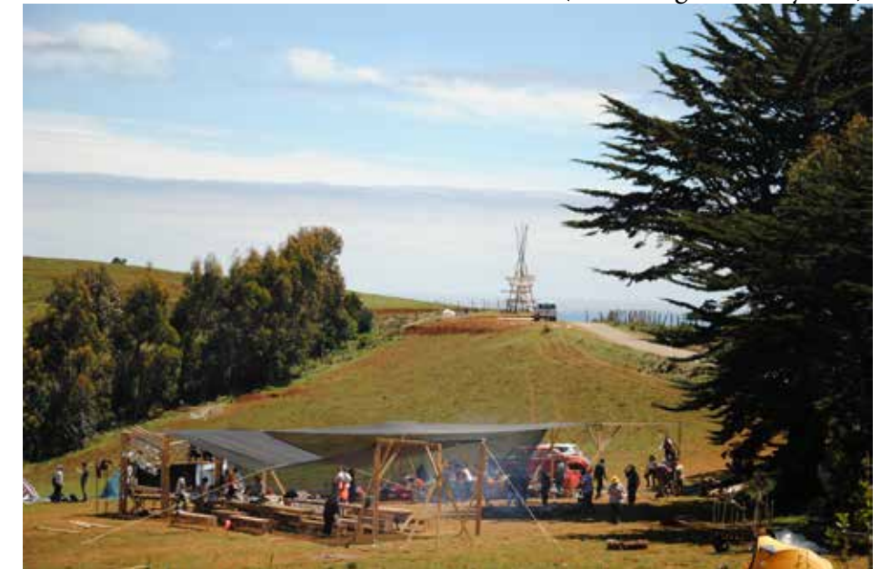
imagen 35. Fotografía, campamento y obra. Por Lucas Bustos
