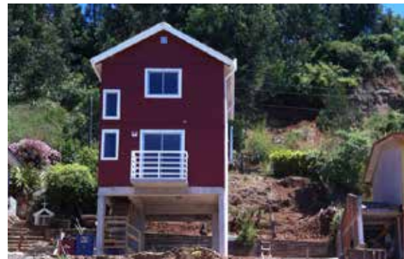
Imagen 134. Ejemplo de Vivienda elevada en Chile posterior al tsunami de 2010. (Worldawardshabitat. (Fotografía) Viviendas sociales resilientes 2016 )
