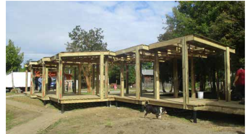
Imagen 40. Fotografía, obra. Por Autor.
