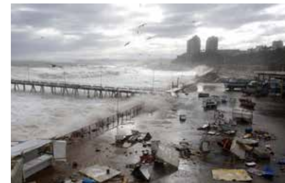
Imagen 129. Inundación por marejada en Caleta Portales Valparaíso, 2015 (Cooperativa 2015).
