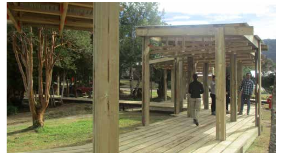
Imagen 41. Fotografía, obra. Por Autor.
