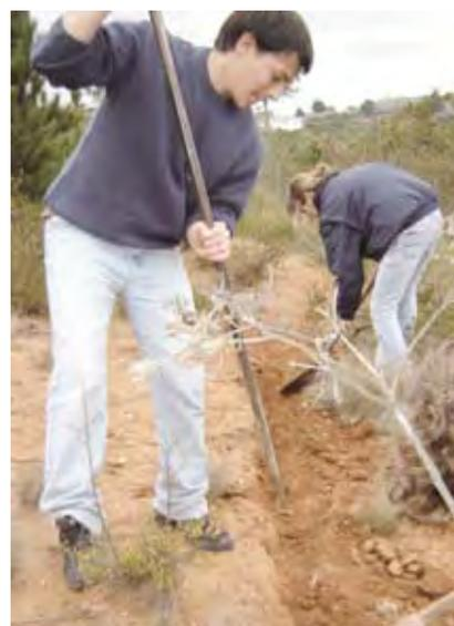
FIGURA III.12 Construcción de surco de infiltración en curvas de nivel.
