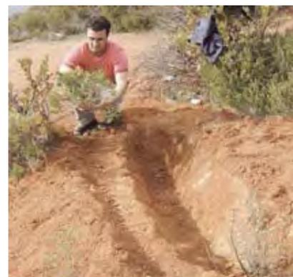
FIGURA III.11 Construcción de zanja de infiltración en curvas de nivel en ladera de cuenca intervenida.
