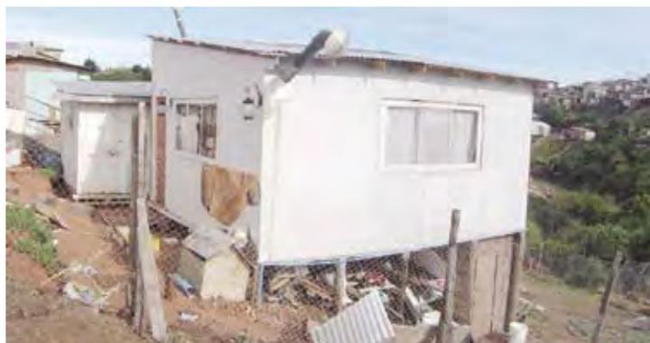
FIGURA II.87 Fotografía de casas con sistema de pilotes en la toma Parcela 11.
