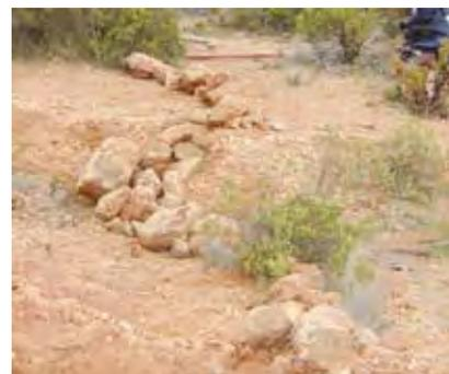
FIGURA III.10 Construcción de pircas en curvas de nivel en ladera de "cuenca intervenida".
