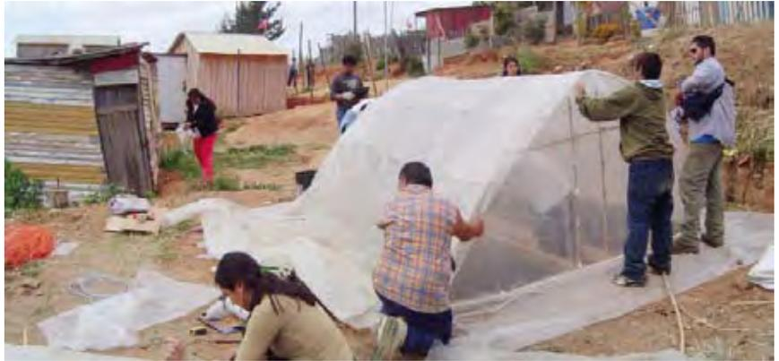
FIGURA III.34 Trabajos de recubrimiento de la cubierta con polietileno.
