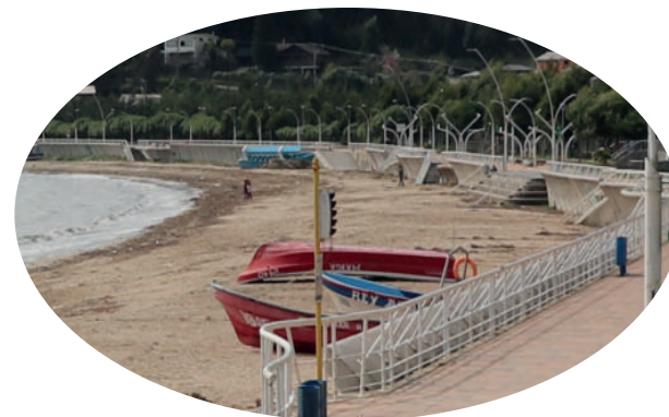
Imagen 110. Detalle muestra muro de protección frente al mar. (Fotografía de Felipe Igualt, agosto 2021.)
