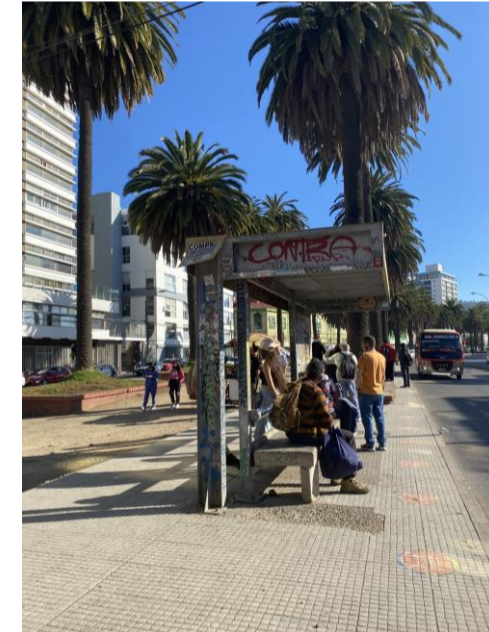
RECORRIDO 2. Para la salida del paradero, nos encontramos con una ruta que no cumple el ancho mínimo para la circulación contenido en 90 cm de ancho con el borde de la calzada y de tope con las palmeras. Elemento palmera obstaculiza el caminar. Además contiene un desnivel de 10 cm deteriorado. El paradero carece de ancho mínimo.
