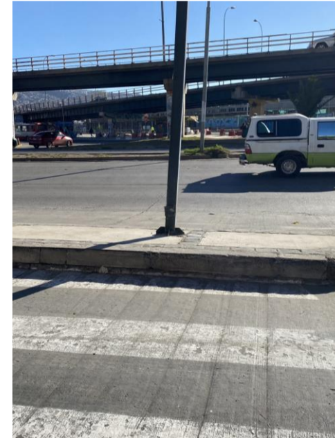
RECORRIDO 1. Cruce peatonal dirigido a la acera, no existe una rampa para el ingreso tampoco una advertencia sonora o una huella de alerta. El cruce lleva a nada. Según DS 50, cruce peatonal debe ser rebajado en todo su ancho hasta igualar la altura con la calzada. Debe existir una rampa antideslizante.
