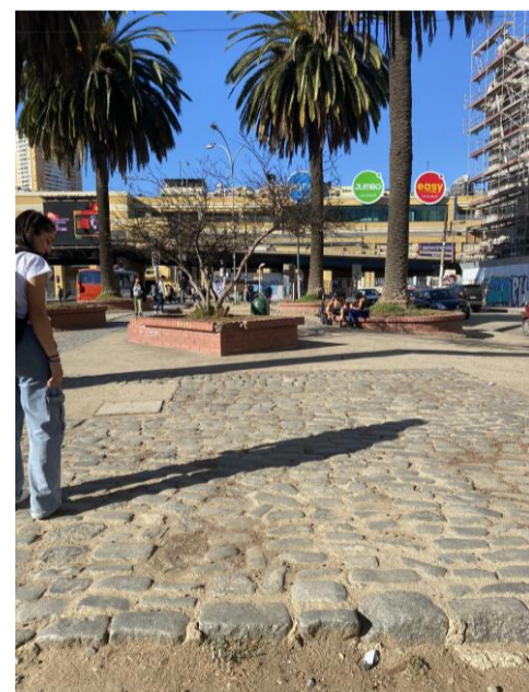
RECORRIDO 2. Según el artículo 3.2.5 de la pavimentación y obras complementarias, el adoquín es un pavimento considerado INACCESIBLE. No se diferencia la ruta accesible con una superficie estable, pues para una persona con movilidad reducida si o si debiera pasar por el adoquín.
