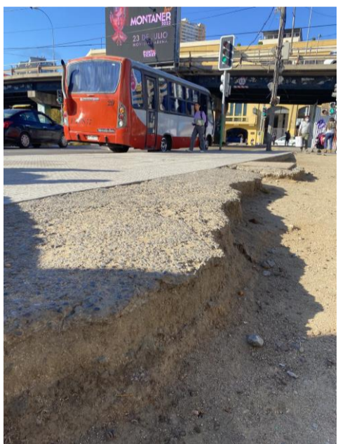
RECORRIDO 2. Para transitar al cruce de av. Brasil nos encontramos con la ruta elevada y en mal estado. Bandedón deteriorado y sin señales de alerta. Pavimento irregular.
