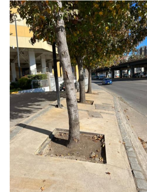
RECORRIDO 1. Acera con pendiente mayor a 2% (7%) y disposición de árboles en medio de la acera. Según DS 50 elementos verticales deben de estar alineados con la acera y no deben obstaculizar el paso y debe haber un contraste de protección de árboles. Pendiente transversal debe ser máxima de 2%, mayor pendiente provocara dificultades de maniobra de persona en silla de ruedas.
