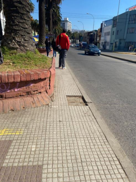
Según DS 50 Los paraderos de locomoción colectiva deberán estar conectados con la ruta accesible, de ancho continuo 120 cm libre de obstáculos, gradas o cualquier barrera que dificulte el desplazamiento y percepción de su recorrido.
