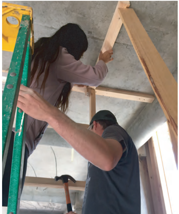
Construcción tabiquería en Pórtico de los Huespedes. Fuente: Elaboración propia.
