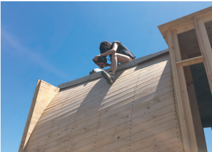
Instación canaletas en Pórtico de los Huespedes. Fuente: Elaboración propia
