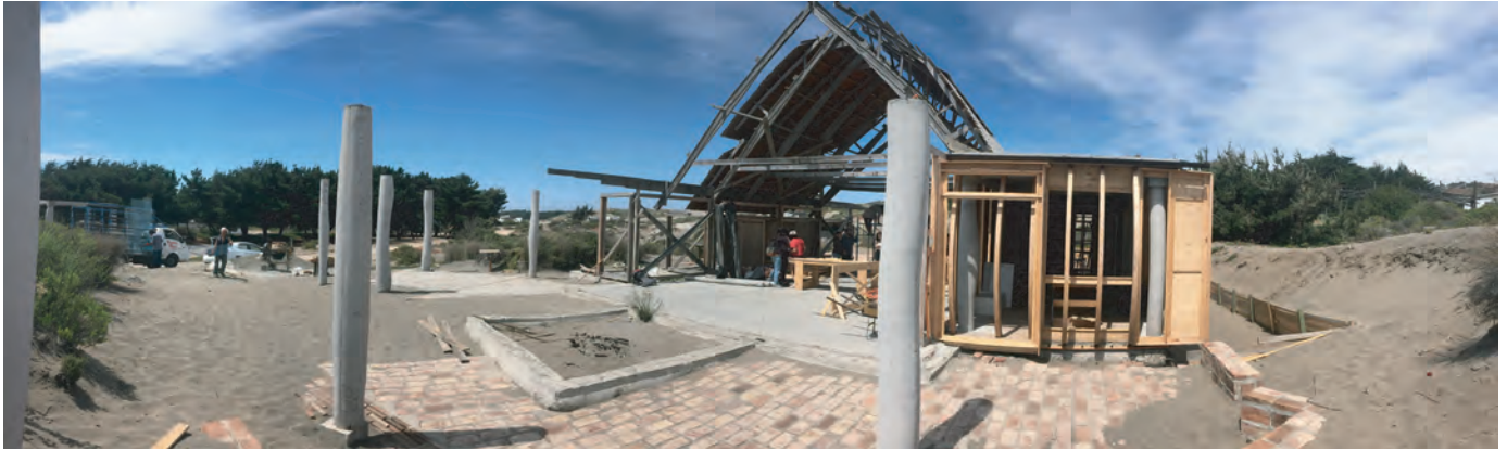
Vista frontal en perspectiva Pórtico de los Huespedes. Fuente: Elaboración propia.
