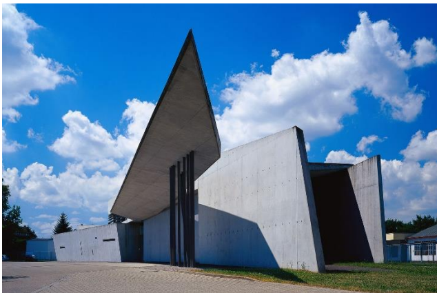
Figura 3. Estación de bomberos
