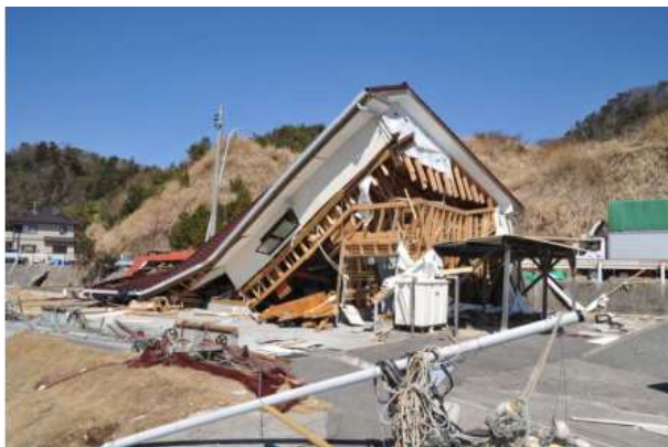
Fig.4. Imagen 5, Casas de construcción en madera, completamente destruída y arrastrada por el tsunami, en el área de Iwaki, Japón, donde la altura de la inundación fue de 5 mtsFuente: Lekkas et al. (2015)
