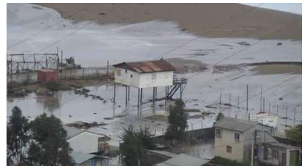
Fig.2. Imagen 3. Vivienda adaptada para el riesgo de inundación por marejada, en el temporal del 8 de agosto de 2015 (Fuente: Web PURANOTICIA)
