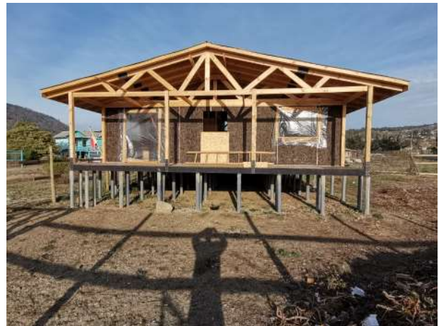
Fig.3. Vivienda con fundaciones adaptadas que la separan del suelo, en la playa de Laguna Verde (Fuente: Elaboración propia)
