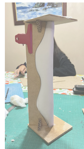
Se vierte el yeso en el moldaje flexible y se deja secar.
