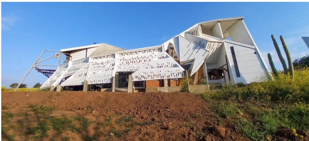
Figura 74 - Fachada Norte HE _ Envolverte de Luz
