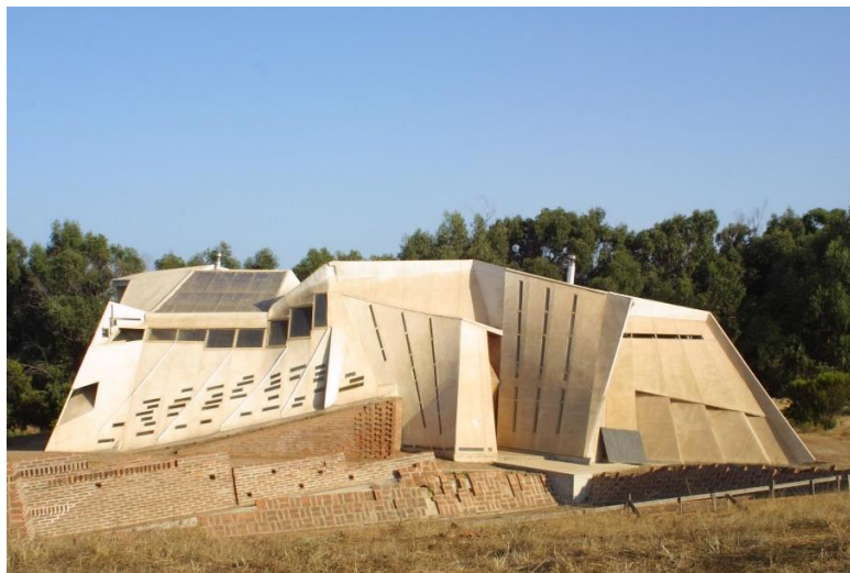
Figura 45- CAO err 02 - 014 - Hospedería del Errante (construcción varios)
