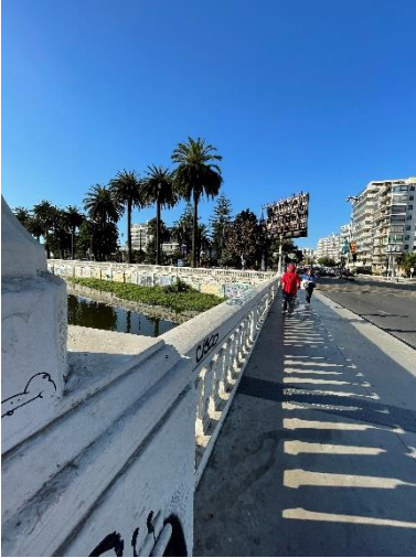
Figura 12: Desde puente casino hacia el norte. Foto propia.
