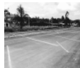
Vista Parcial del Signo construido en la carretera.
