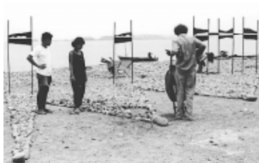
Vista Total de la Obra.
