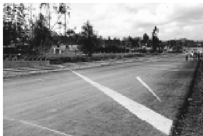
Vista Parcial del Signo construido en la carretera.
