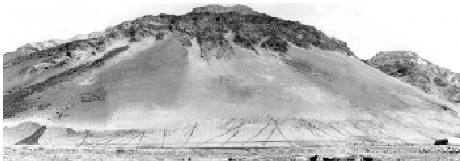
Vista Total de la Obra.
